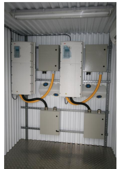
Eget rom for frekvensomformerer med tilkoblingskap og Roxtec gjennomføringer
